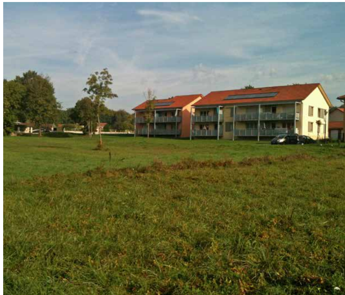
Logements collectifs, Porcieu Amblagnieu
