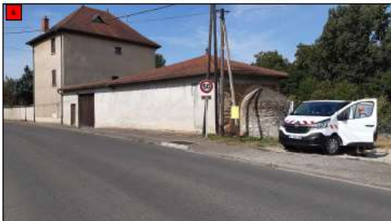
Le long de la RD 18 à proximité de la canalisation intercommunale de transit d'eaux usées
