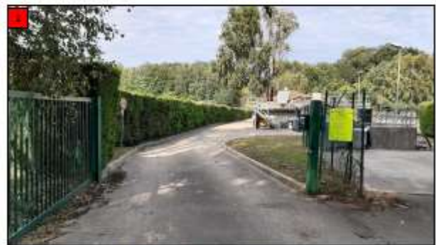
Entrée de la station d'épuration de la LYSED
