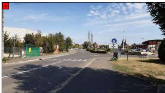
Sur le poste de refoulement des Ardennes le long de la rue des Ardennes à Tignieu-Jamezyieu
