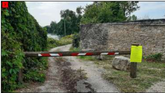
Entrée du poste de refoulement du Bouchet
