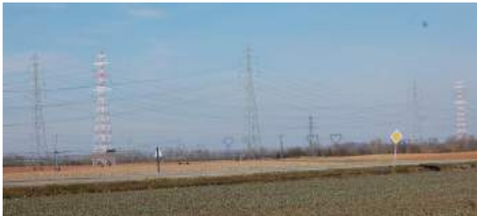
Un espace aérien fragmenté par les lignes électriques
