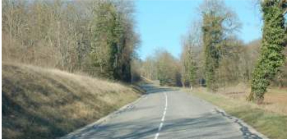
Un facteur important de la fragmentation du territoire : les infrastructures routières
