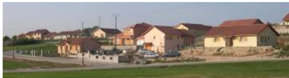
Logements à Arandon
